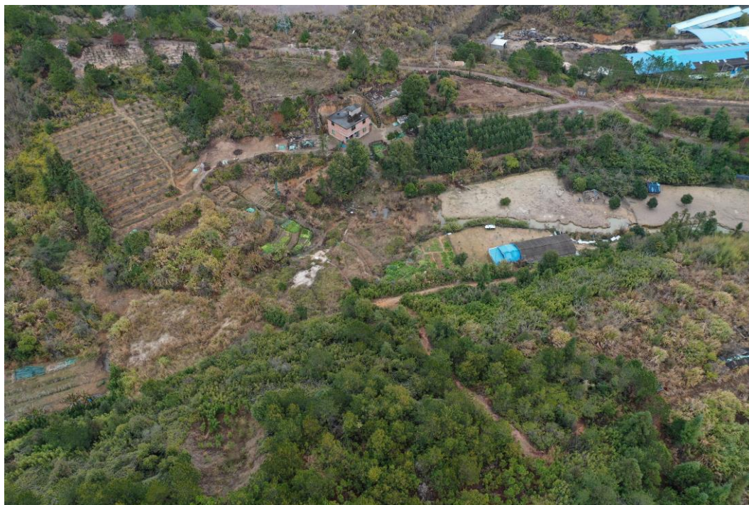
图 3-1 双茶亭稀土矿废弃地治理航拍
